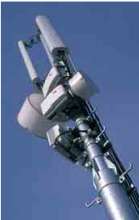
Mât supportant des antennes de téléphonie mobile (tout en haut) et des antennes de faisceaux hertziens (rondes). Ces dernières relient les stations de base aux centrales téléphoniques.
