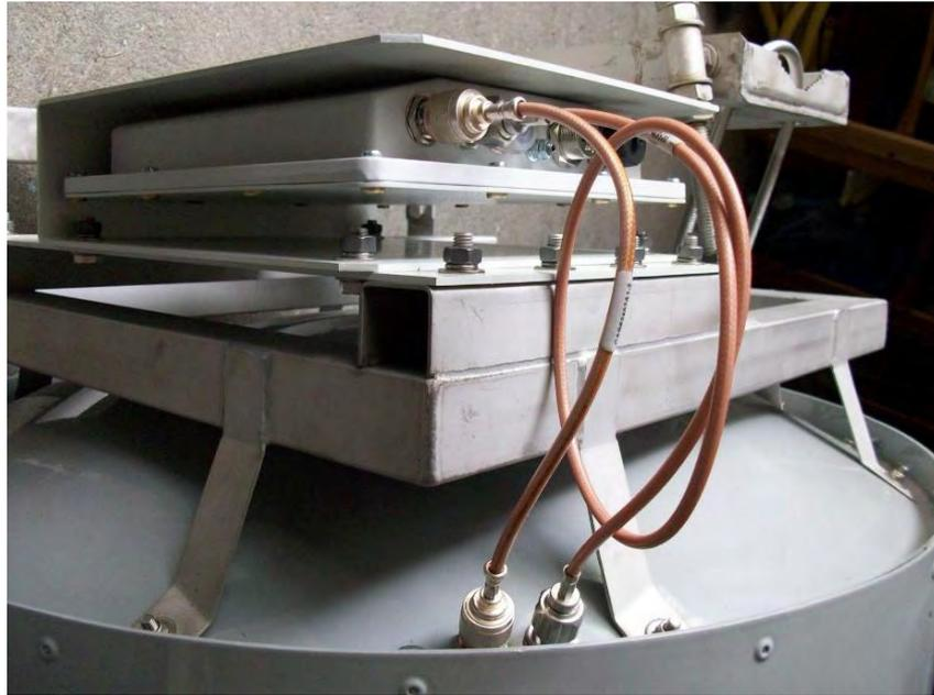
9.4.1.1.2 *Détail du montage de la radio et des raccordements vers la source intégrée FURAK 10-S*
